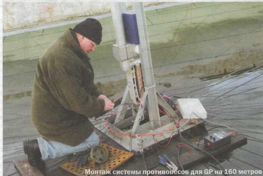
**Монтаж системы противовесов для GP на 160 метров**
