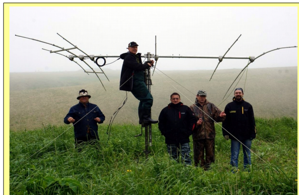
о. Анучина. Демонтаж антенны XL-222E
