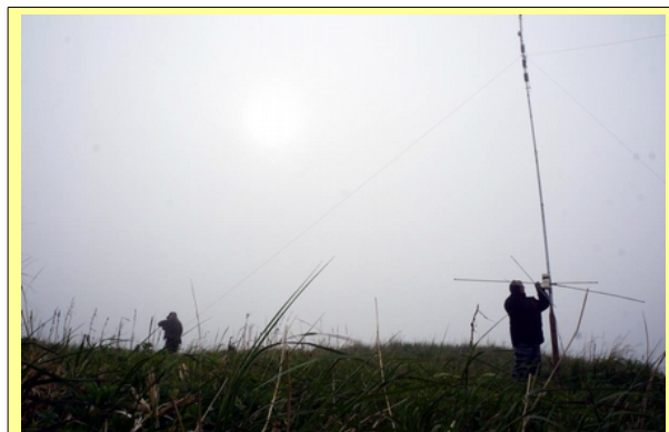
о. Анучина. Установка вертикала на высокочастотные диапазоны.
